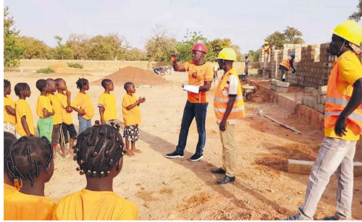
Ganz praktisch auf der eigenen Baustelle: Berufswahlunterricht in Burkina Faso.
