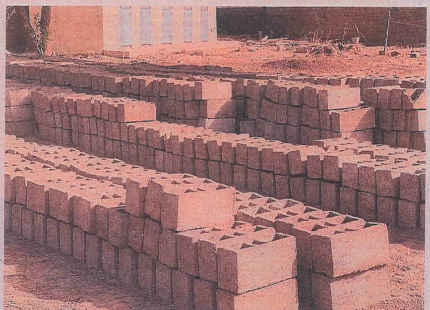
Einige Backsteine sind da, aber mehr Sand, um weitere Backsteine zu machen, kann wegen der unsicheren Lage aktuell nicht besorgt werden.
