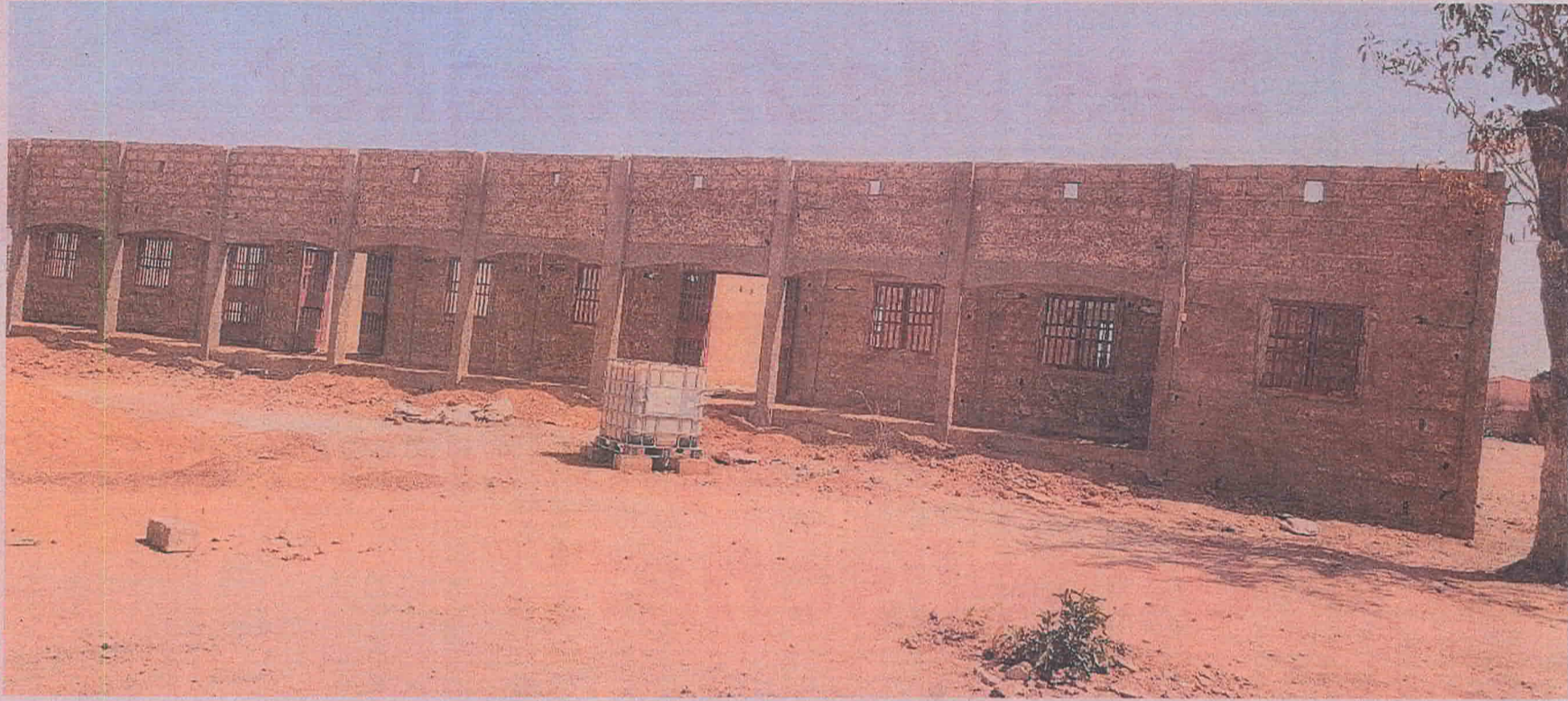
Der Kindergarten für das Centre St. Georges ist am Entstehen. Verschiedene Gründe sorgten für Verzögerungen.
