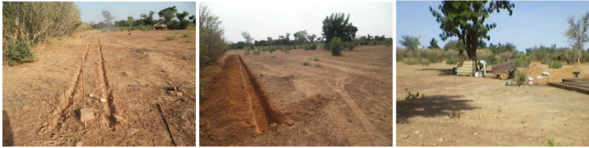
Baustart im November 2012 mit der Umrandung der Grundfläche
